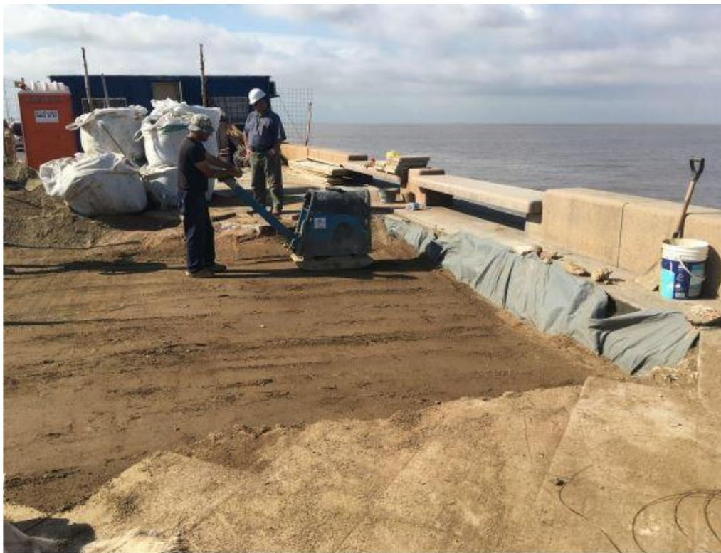
**Foto 3: Ejemplo de relleno en tramos horizontales**
