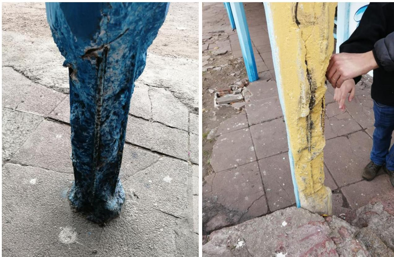
Figura 1: Fotos de dos de los pilares con patologías
